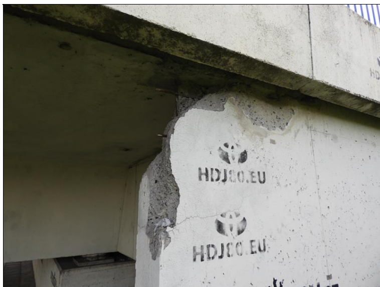
Rozpad betonu levého křídla OP1.
