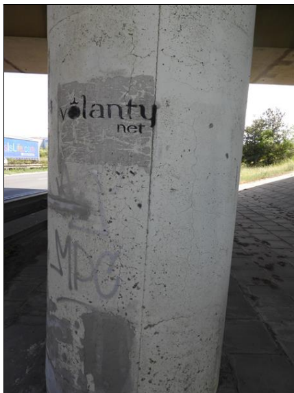
Levý sloup P2, síť trhlín. Degradace betonu sloupu.
