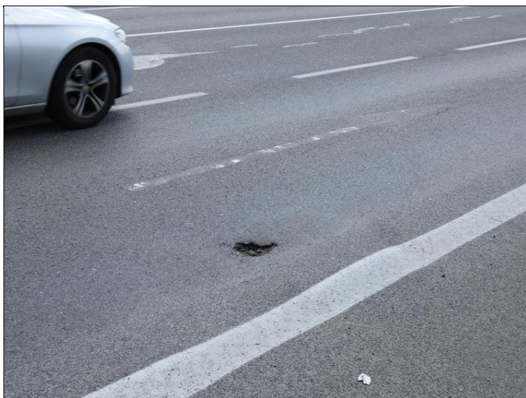
Stav vozovky, výtluk, vyjeté koleje.
