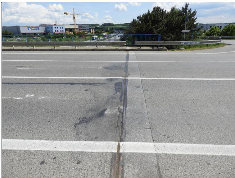
Asfaltobeton ve spáře závěru nad OP1.
