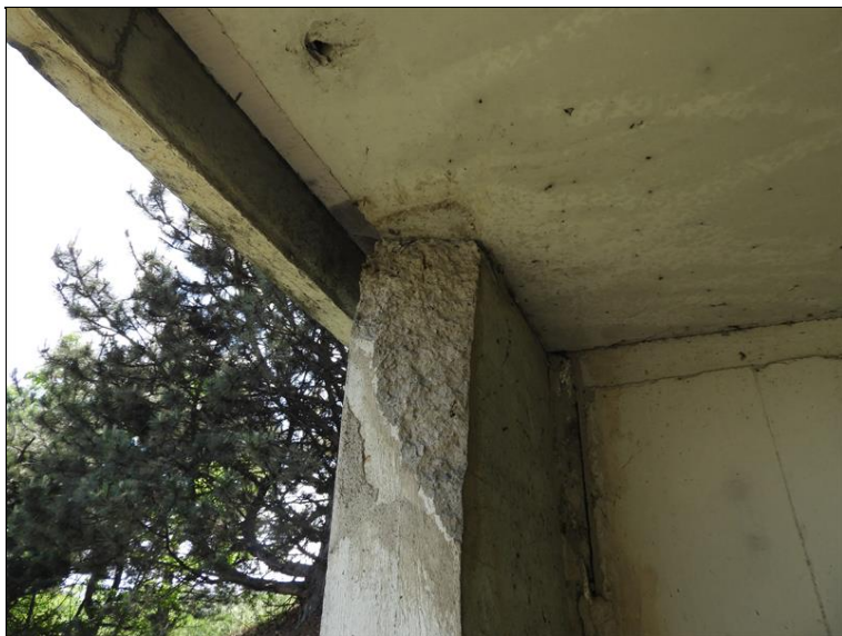
Rozpad betonu pravého křídla OP1.
