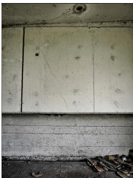
Šikmá trhlina na koncovém příčnicku, která se kopíruje do závěrné zdi OP4.
