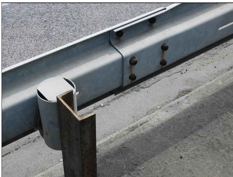
Koroze spojovacího materiálu svodidel, koroze sloupků svodidel.
