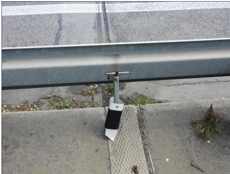
Poškozený směrový sloupek na svodidle.
