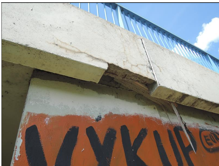
Odlomení spodní části prefabrikátu pravé římsy u OP4.
