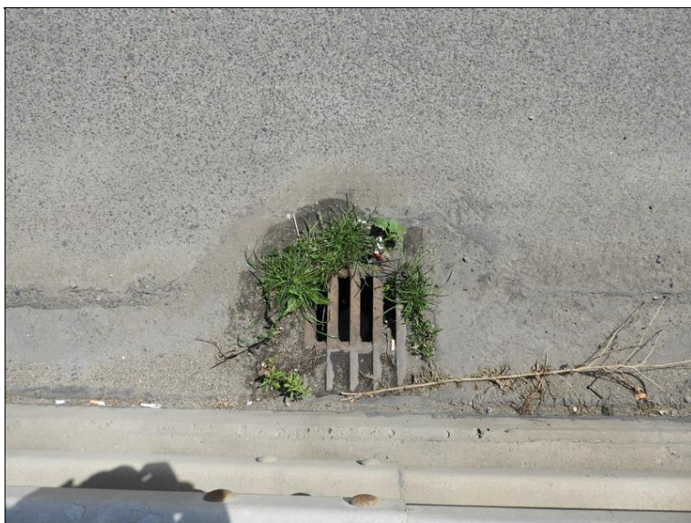
Zanesený odvodňovač, výskyt vegetace.
