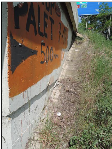
Zanesený skluz u pravého křídla OP4.
