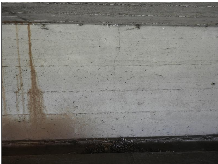
Trhliny v úložném prahu OP1.
