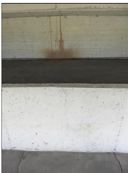
Trhliny v úložném prahu OP1.
